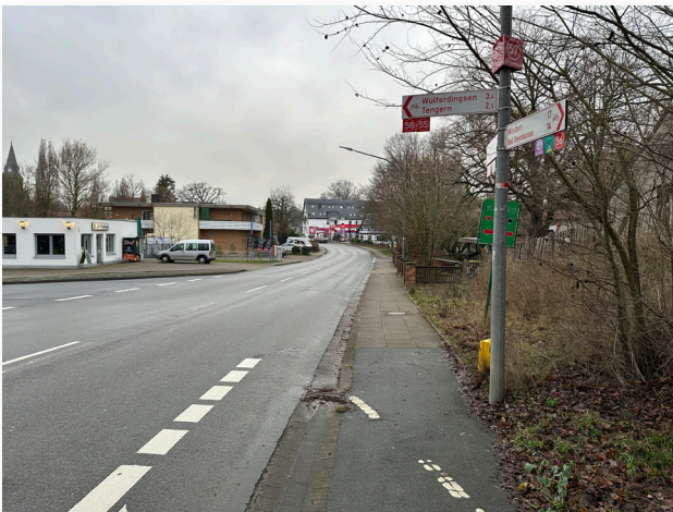
Abb. 106: Fehlende Querungshilfe Mindener Straße (Foto: Ge-Komm GmbH)
