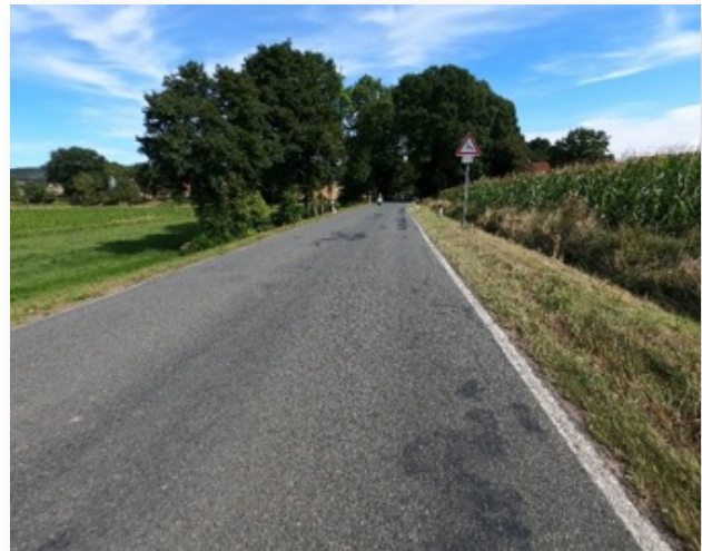
Abb. 84: Alte Straße (L 876) (Foto: Ge-Komm GmbH)
