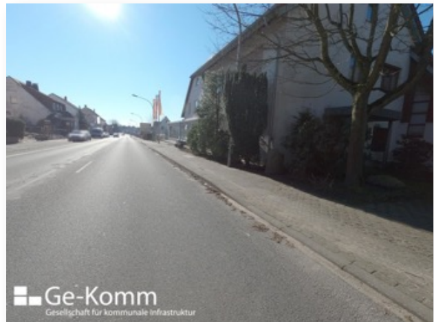
Abb. 137: Löhner Straße (L 773) (Foto: Ge-Komm GmbH)
