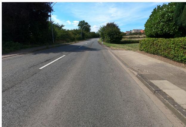
Abb. 99: Radweg Ende Oberbauerschafter Straße L 876 (Foto: Ge-Komm GmbH)
