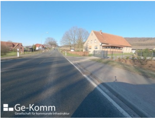
Abb. 111: Fehlende Querungshilfe Ahlsener Straße (Foto: Ge-Komm GmbH)
