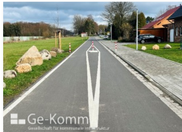
Abb. 97: Sperrpfosten (Foto: Ge-Komm GmbH)
