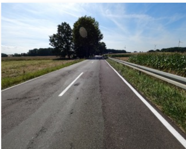
Abb. 80: Oeynhausener Straße K 27 (offizielle Radroute) (Foto: Ge-Komm GmbH)
