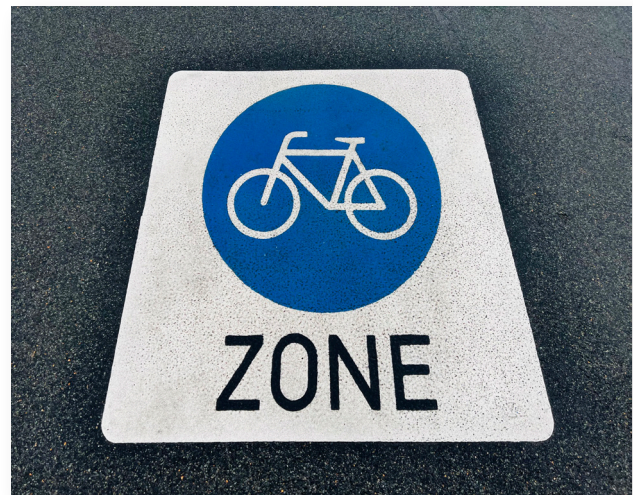
Abb. 29: Fahrbahnmarkierung Fahrradzone (Foto: Ge-Komm GmbH)
