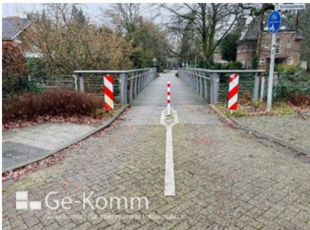
Abb. 95: Sperrpfosten (Foto: Ge-Komm GmbH)
