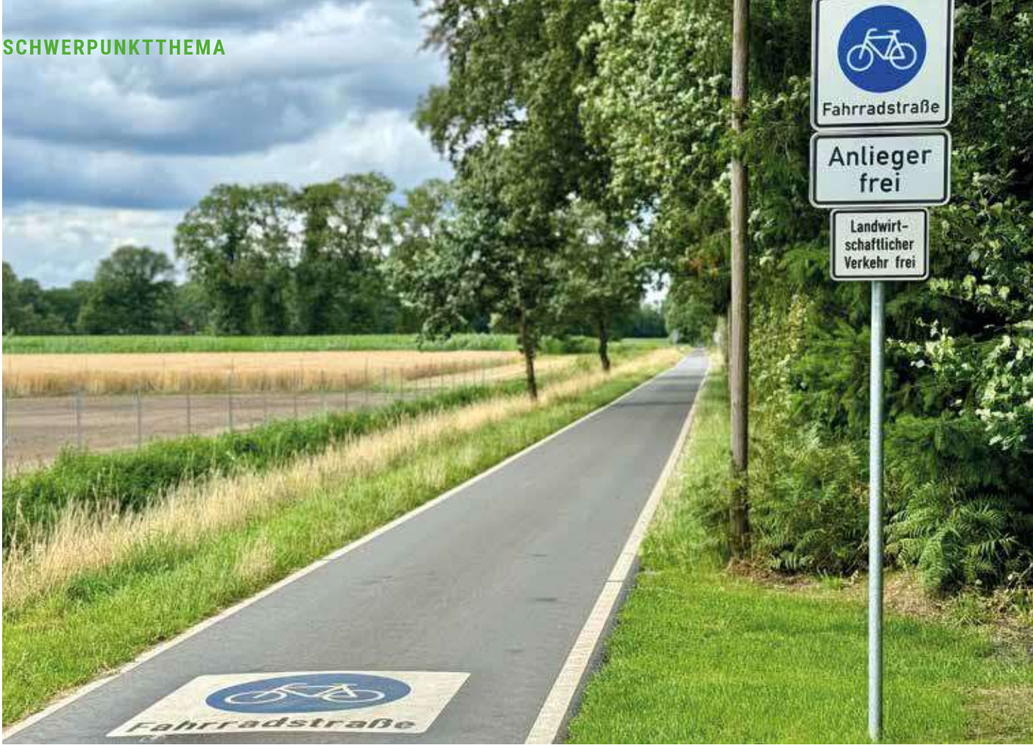
Fahrradstraßen können auch auf Wirtschaftswegen eingerichtet werden. – Foto: Ge-Komm GmbH
